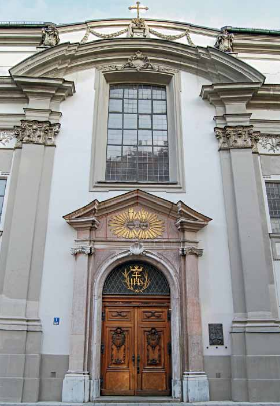
Außenansicht der St. Anna-Damenstiftskirche
